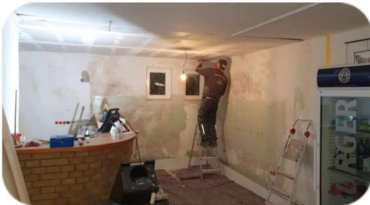
„Schloti“ kümmerte sich z. B. um die Wände, spachtelte, verputzte und strich sie auch gleich neu, teils antiquierte Stromkabel wurden ausgetauscht, neue Sicherungen eingebaut und neue Steckdosen gesetzt, Bodenfliesen wurden gegen neue getauscht, und, und, und...
